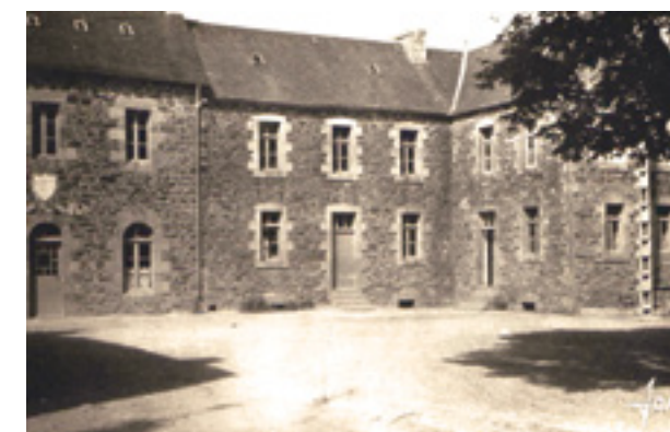
Le Foyer : Les bâtiments principaux en 1953
